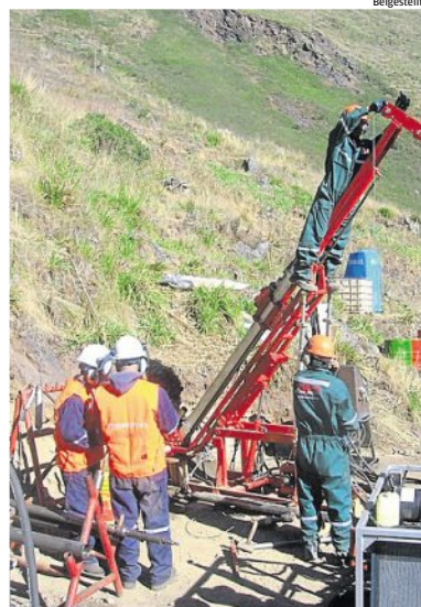
Aurex führt Bohrarbeiten in bis zu 1,80 Metern Tiefe durch.
